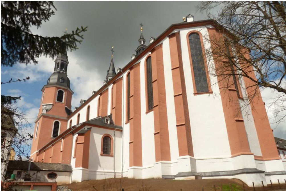
Abbildung 39: Außenansicht der St. Salvator-Basilika in Prüm mit Blick auf die Apsis
