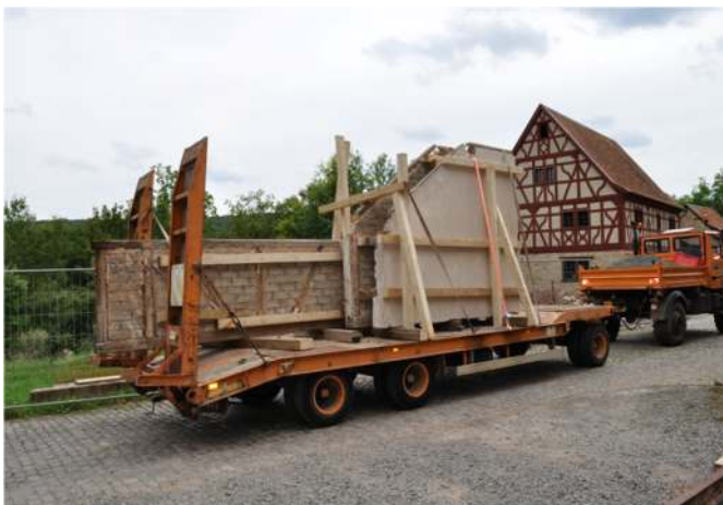
Abbildung 40: Transport der Giebelwand
