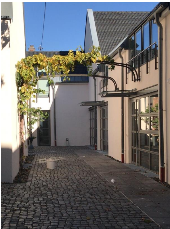
Der neu gestaltete Innenhof
