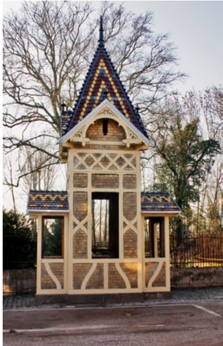
Das Uhren- und Wiegehäuschen von Bretzenheim nach der Restaurierung
