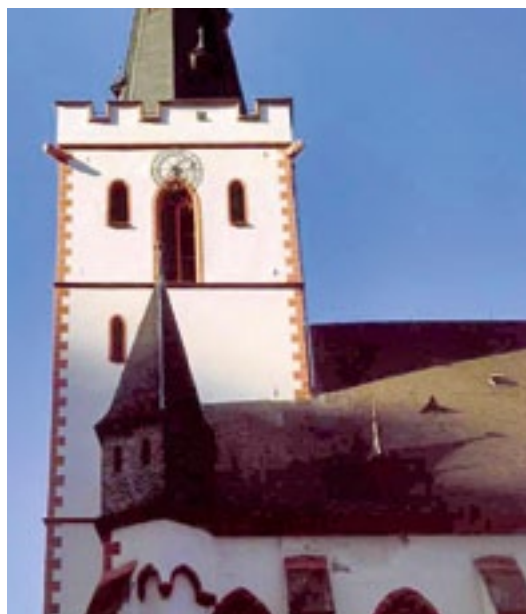
Turmanlage nach den Sanierungsarbeiten
